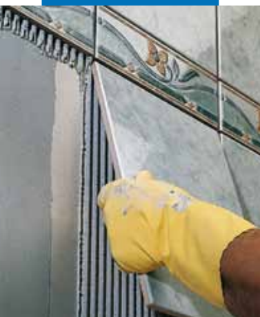
Pokládka jedenkrát pálených obkladů na sádkartonu
