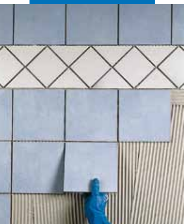
Pokládka jedenkrát pálených obkladů v koupelně na omítku
