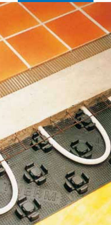
Lepení keramické dlažby na topný podlahový systém
