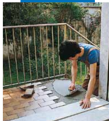
Hydroizolační stěrka a následné lepení dlažby s použitím Kerabond T + Isolastic
