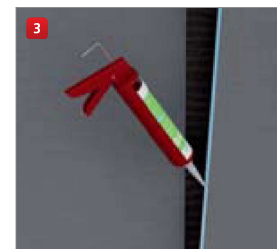
3 ... utěsněte a vyztužte spoje armovací páskou ...
