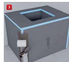
3 ... vyztužte spoje armovací páskou ...
